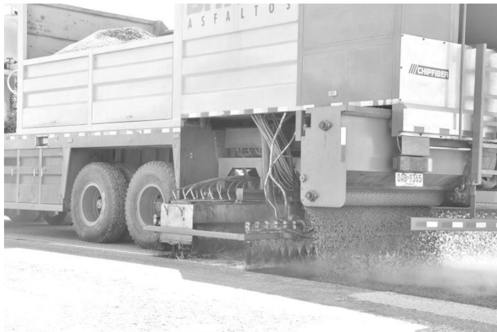
Figura 6: Aplicación del tratamiento con fibra y asfalto regado a 165°C
