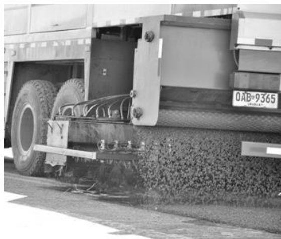
Figura 2: Equipo aplicando el tratamiento superficial reforzado con fibra de vidrio
