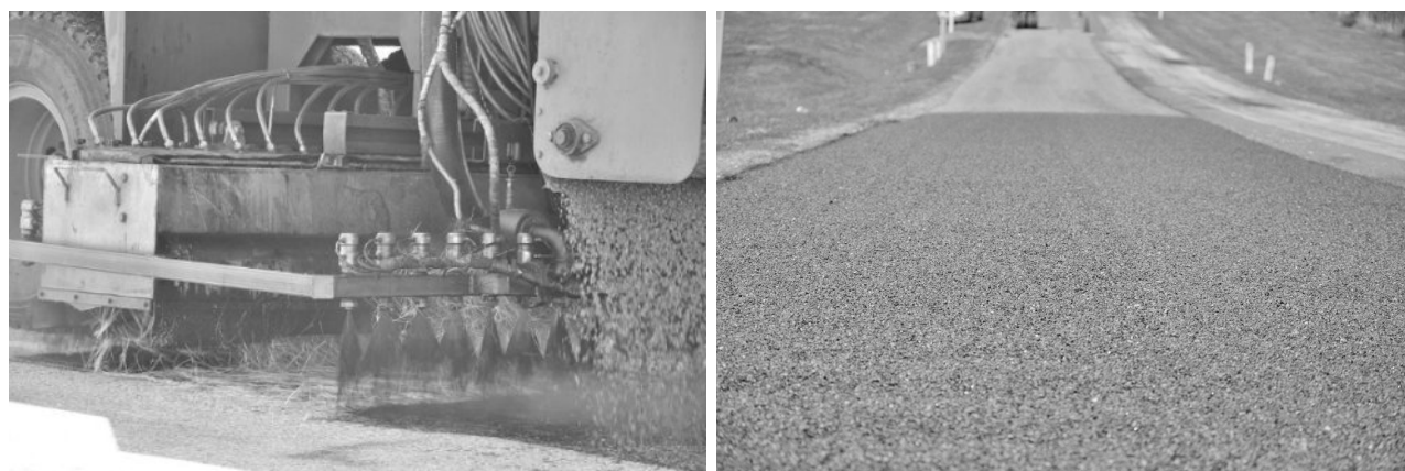
Figura 4: Imágenes durante y luego de la aplicación del tratamiento con emulsión
